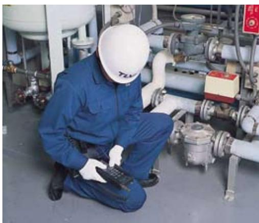
Dados requeridos para registro do purgador - tipo de purgador, diâmetro, pressão de operação, tipo de operação, etc.
